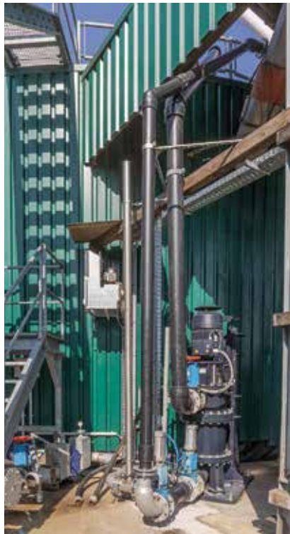
△ Der PlurryMaxx im Bypass-Verfahren das vorgegorene Substrat aus dem Fermenter.
